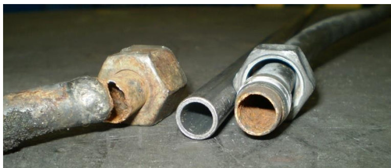
Obr. 14: Nežádoucí agresivní účinek proplachovacího čisticího média na přívodních trubkách chladicího okruhu
